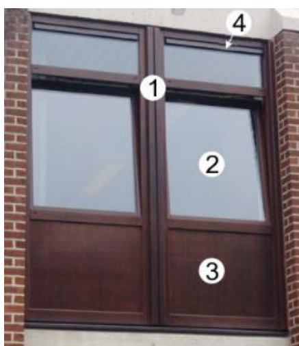
Figure 21 : Les différentes parties d'une fenêtre (source - www.energieplus-lesite.be )
