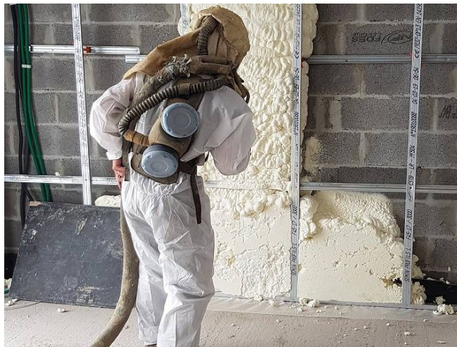
Figure 2 : Exemple d'application de mousse expansive sur une paroi verticale
